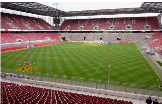
Abb. 6: Ansprechender Gesamtaspekt des Rasens im Rhein-Energie-Stadion Köln. Im Vorder- und Hintergrund Belichtungseinheiten für den Strafraum.
